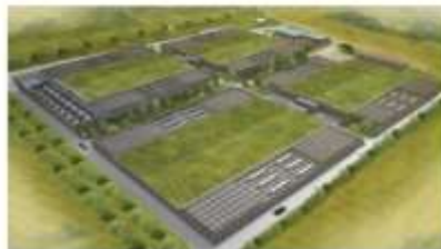
Avalon UK 120MW
